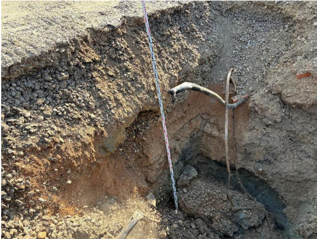
Foto 19: Angetroffene Leitungen (SB-2)
