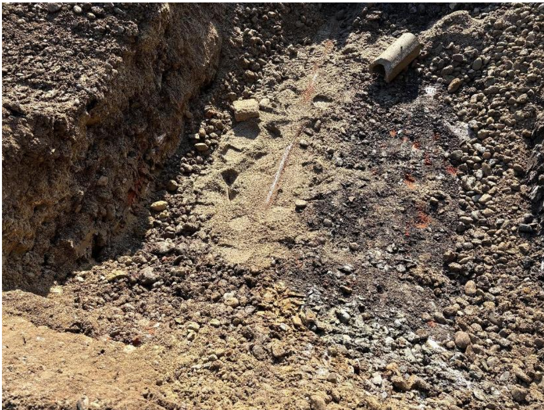
Foto 18: Angetrofenes Kabelrohr (SB-2)
