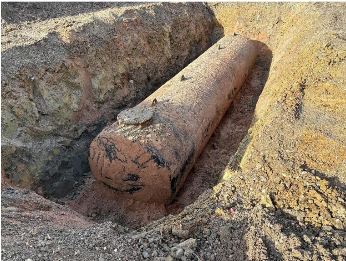
Foto 23: Freigelegter 30 000 l Dieseltank
