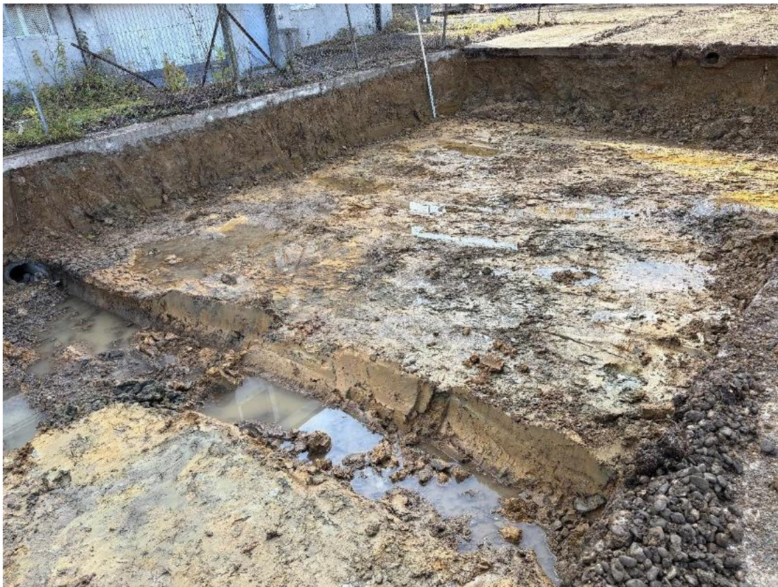
Foto 8: Ausgehobener Bereich (SF-1)
