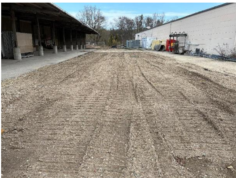
Foto 12: Aufgebrochene Sanierungsfläche
