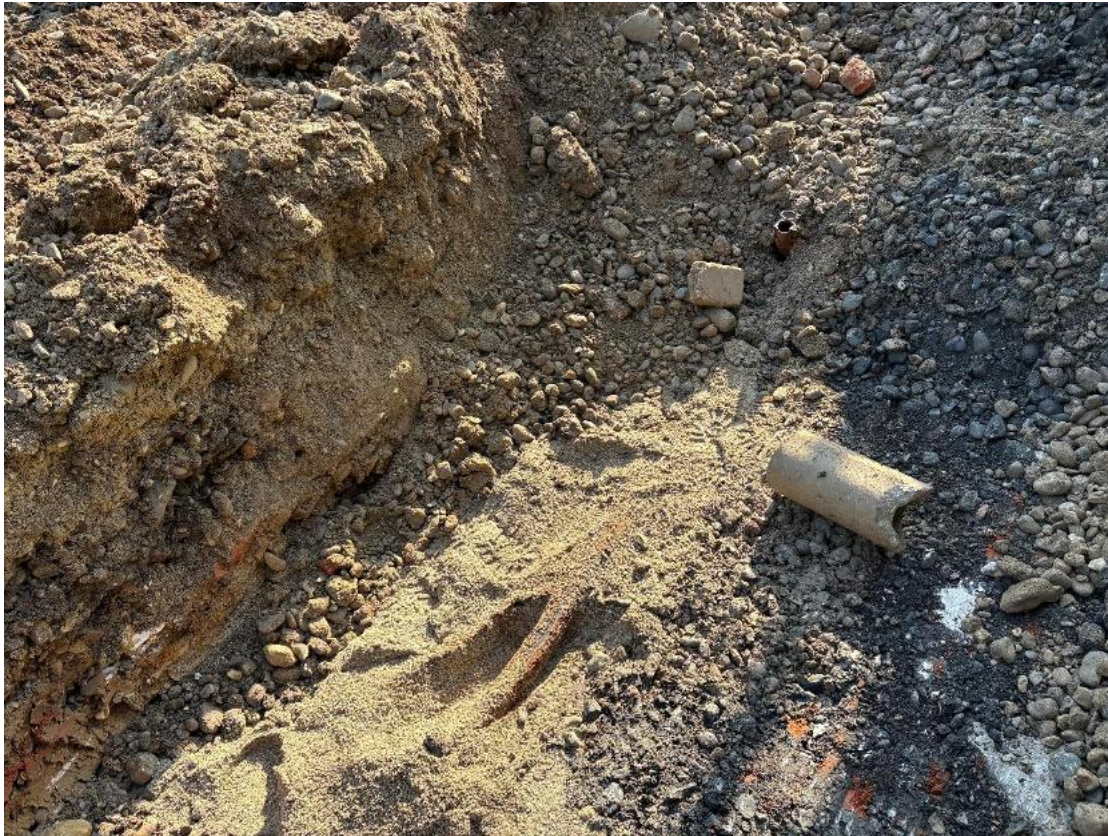
Foto 17: Angetrofenes Kabelrohr (SB-2)
