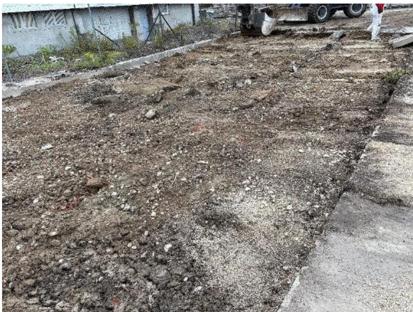
Foto 6: Aufgebrochene Sanierungsfläche
