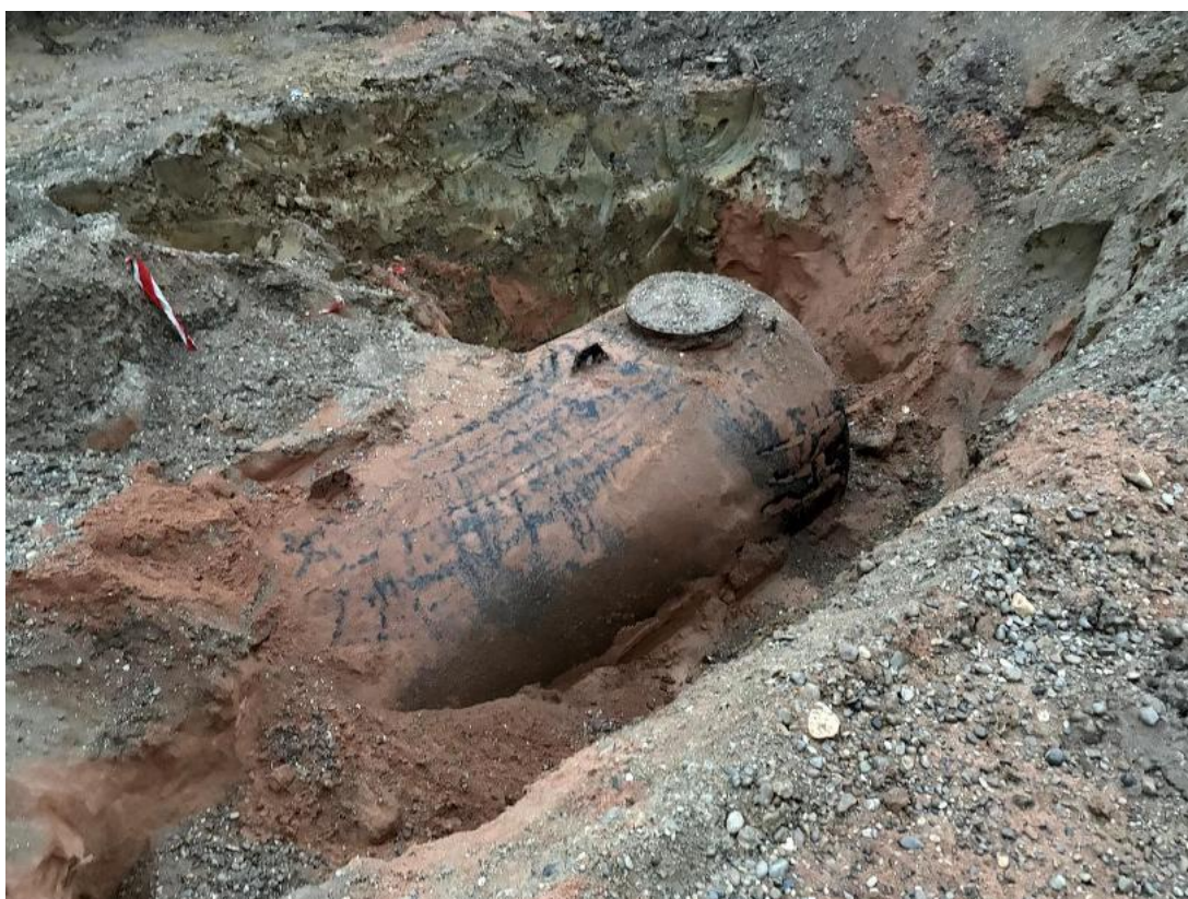
Foto 22: Freigelegter 30 000 l Dieseltank
