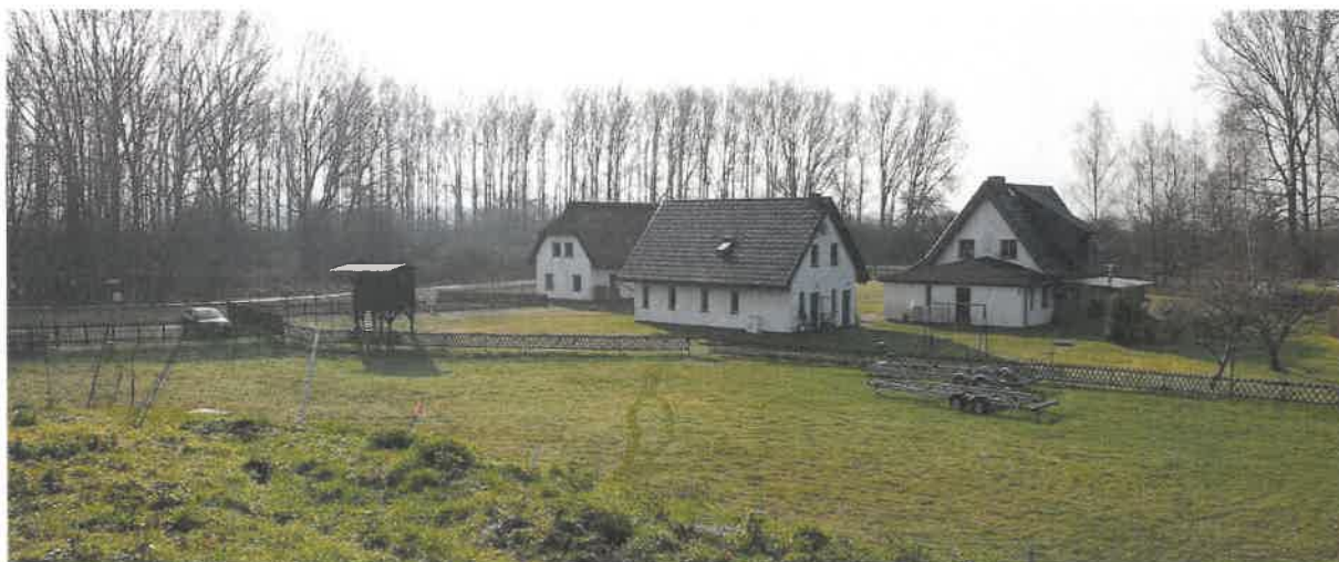
Abbildung 3: Siedlung Weddeort mit Rasenflächen und Bestandsgebäuden
