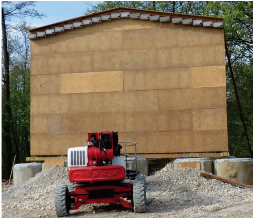
Abb. 6: Ersatznistplätze für Mauersegler
