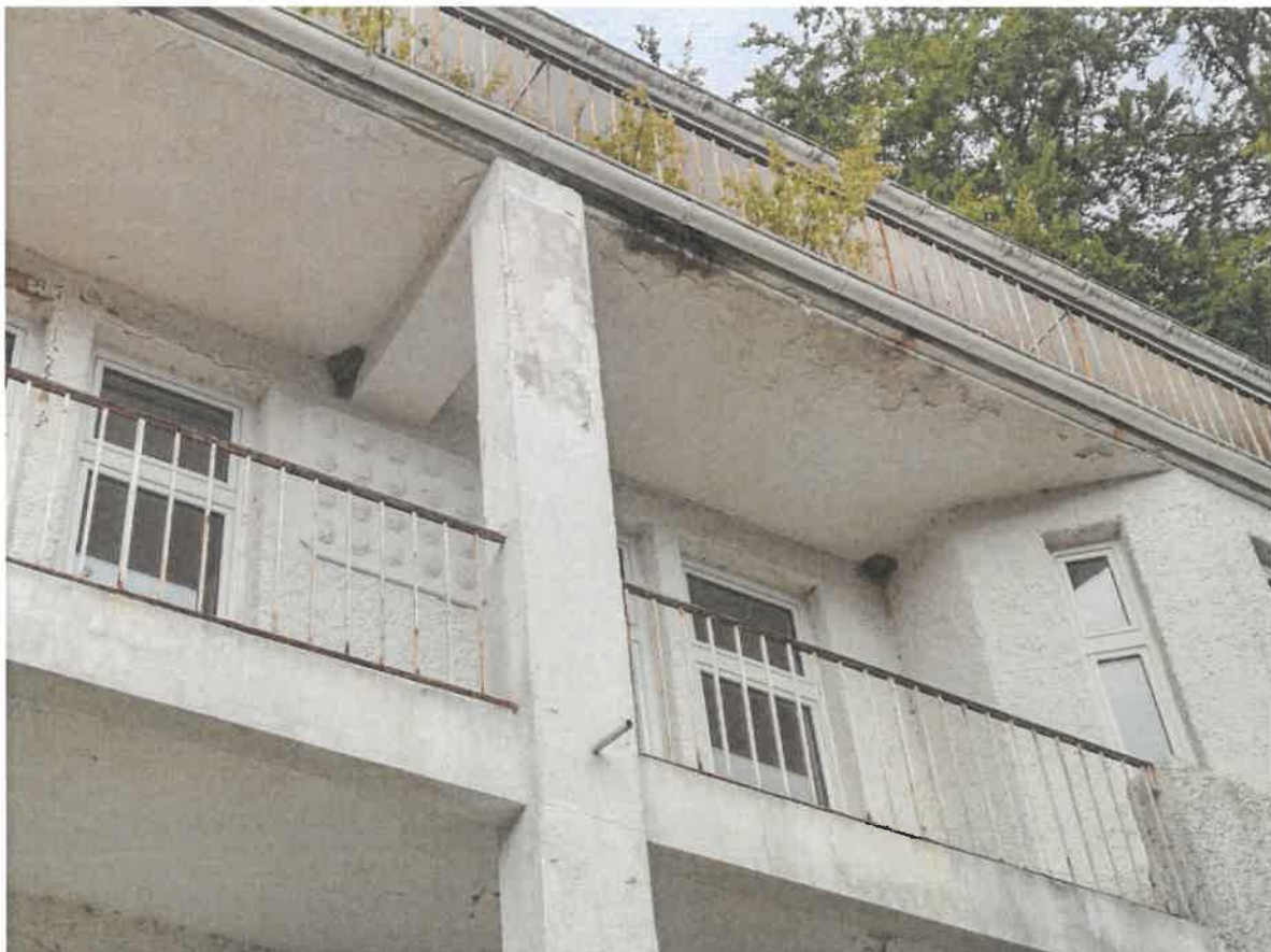
Abbildung 13: Zwei bebrütete Mehlschwalbennester auf der Ostseite des Gebäudes.
