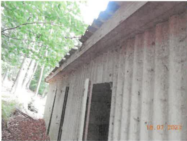
Abbildung 4: Schuppen nördlich der Villa
