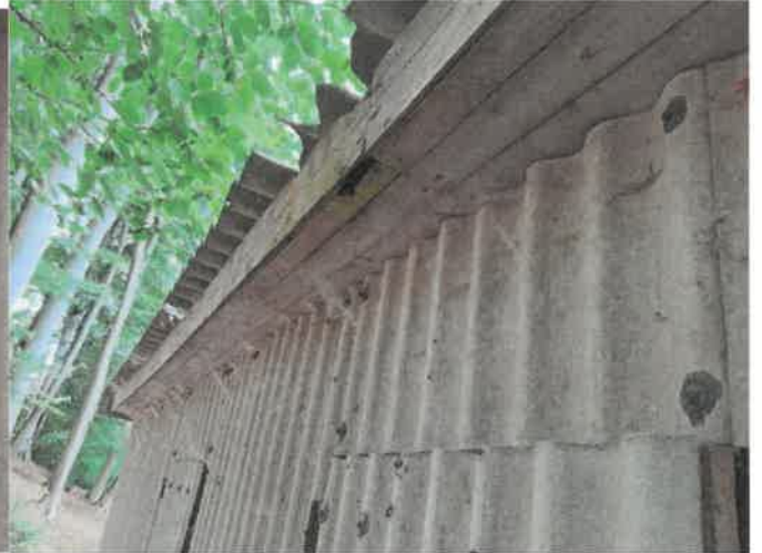
Abbildung 5: potenzielle Einflugstelle für Fledermäuse
