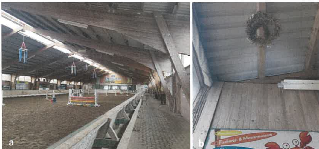
Abb. 5: Innenansicht der Reithalle im Grünen Weg in Burg auf Fehmarn (a) und Detailansicht der südöstlichen Gebäudeecke mit dem frei liegenden Blechdach und dem Wandanschluss (b).
