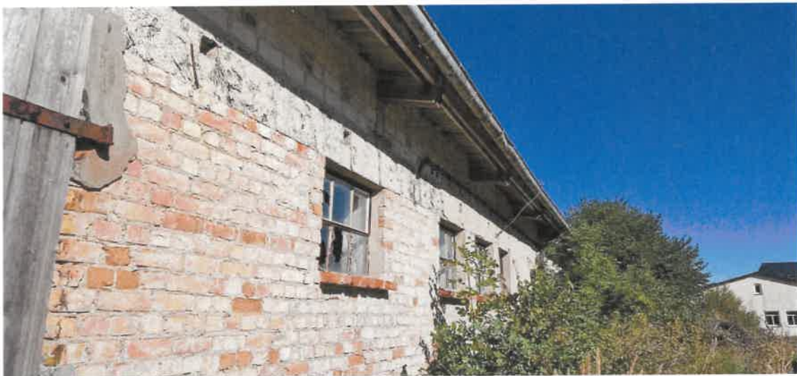
Abbildung 40: Die Südwestseite von Gebäude 1 weist keine Mehlschnalbenester auf.
