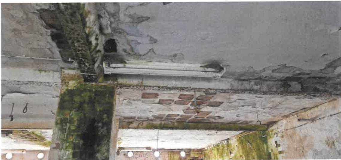
Abbildung 34: Rauchschnalbenester auf Lampen in Gebäude 2.
