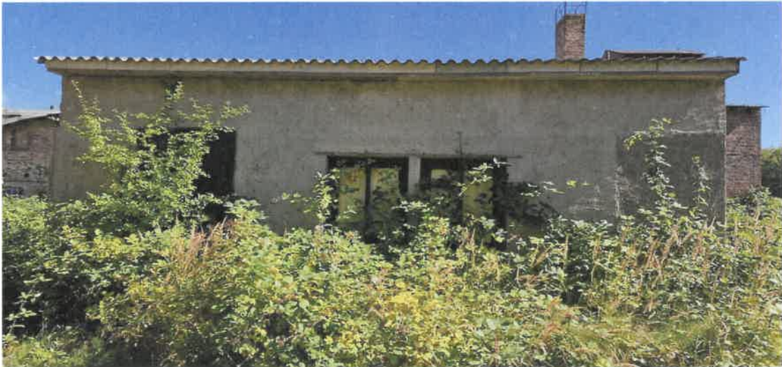
Abbildung 12: Nordwestseite von Gebäude 3.
