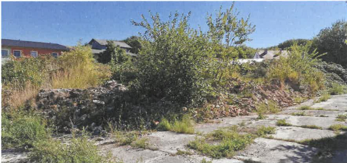
Abbildung 18: Bewachsene Schuttablagerungen südwestlich von Gebäude 2.
