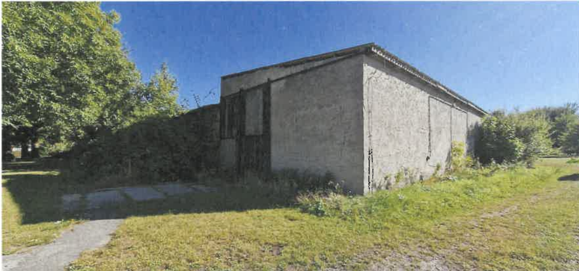
Abbildung 42: Die Giebelseite von Gebäude 1 ohne Risse und Nester.
