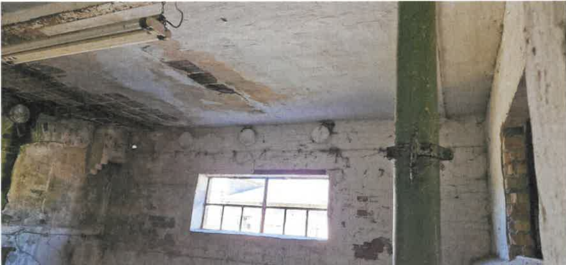
Abbildung 30: Innenbereich im Erdgeschoss von Gebäude 2 mit Rauchschnalben.
