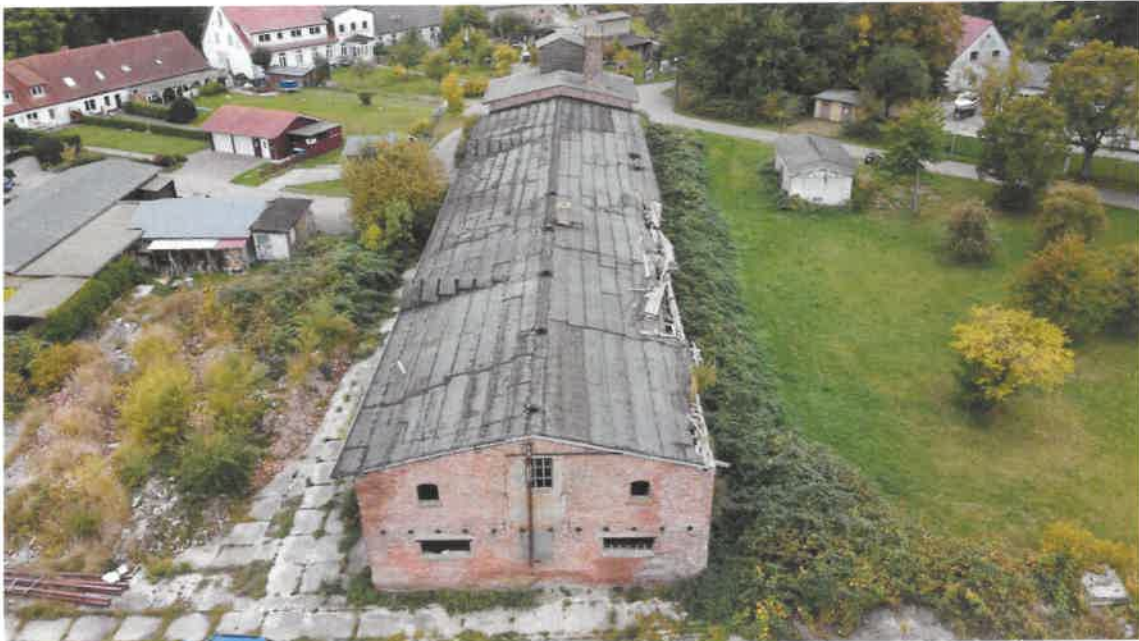
Abbildung 5: Blick aus Nordosten in den Geltungsbereich und Gebäude 2 und 3.
