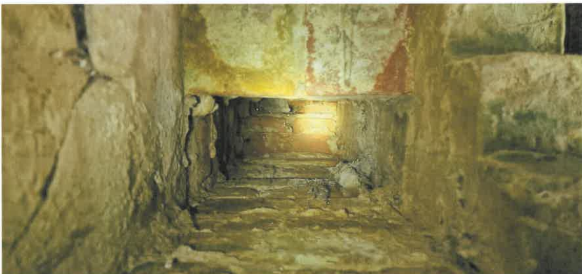
Abbildung 31: Schächte im Innenbereich von Gebäude 2.
