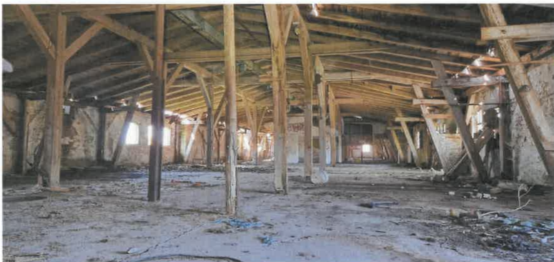
Abbildung 19: Obergeschoss im mittleren und nördlichen Teil von Gebäude 2.
