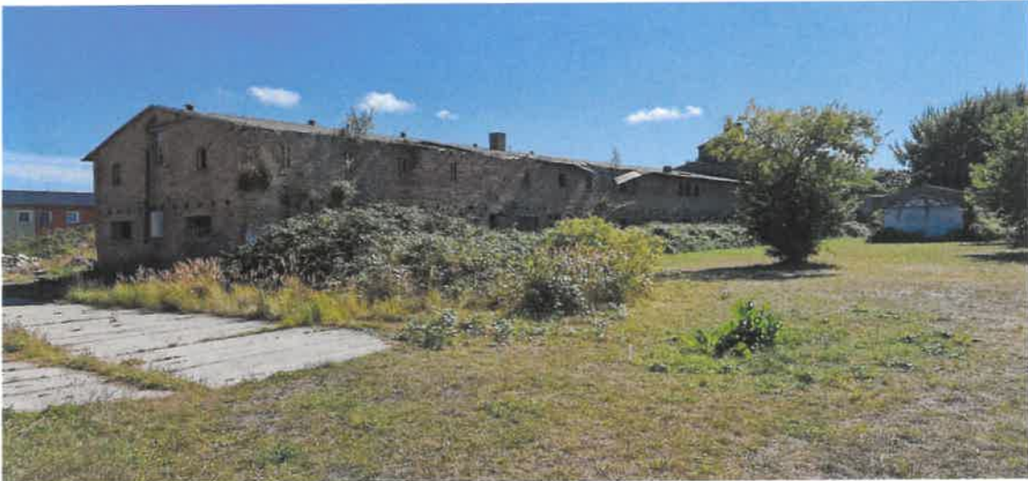
Abbildung 9: Blick aus Norden auf Gebäude 2 und 3.
