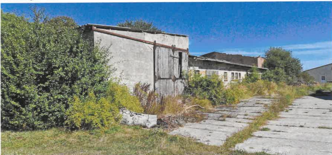
Abbildung 10: Blick aus Nordwesten auf Gebäude 1.
