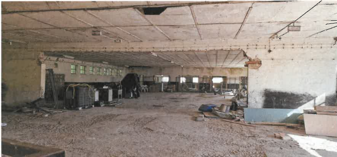
Abbildung 36: Innenbereich von Gebäude 1, südöstlicher Teil.
