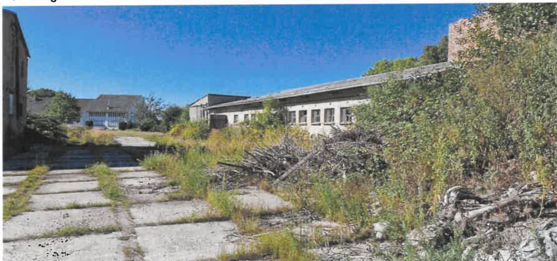
Abbildung 29: Bereich zwischen Gebäude 1 (rechts) und Gebäude 2.
