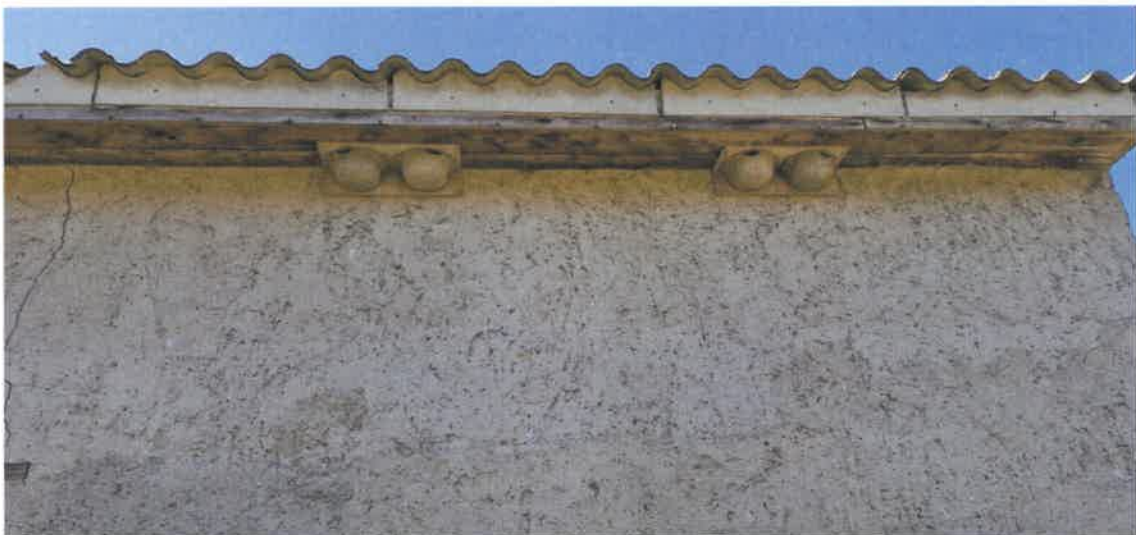
Abbildung 13: Nisthilfen für Mehlschalben mit Kotspuren an der Südostseite von Gebäude 3
