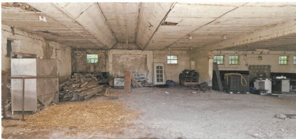
Abbildung 37: Innenbereich von Gebäude 1, nordwestlicher Teil.
