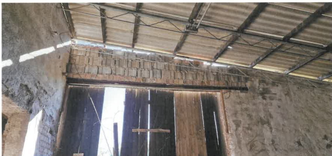
Abbildung 38: Hohlblocksteine mit Quartiermöglichkeiten für Fledermäuse.
