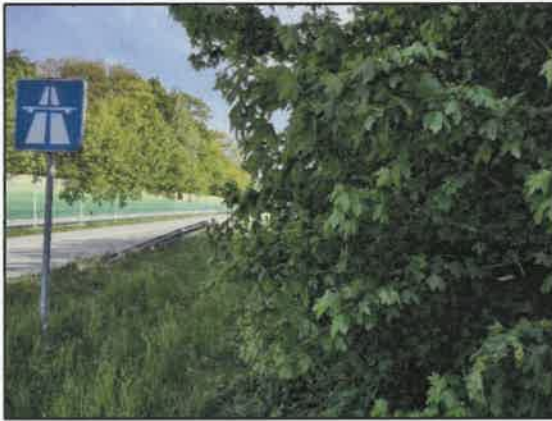
Abbildung 6: Auffahrt auf die BAB1 mit angrenzender Gehölzstruktur; Blickrichtung Südosten (Foto: Planungsbüro ALSE 16.05.2022)
