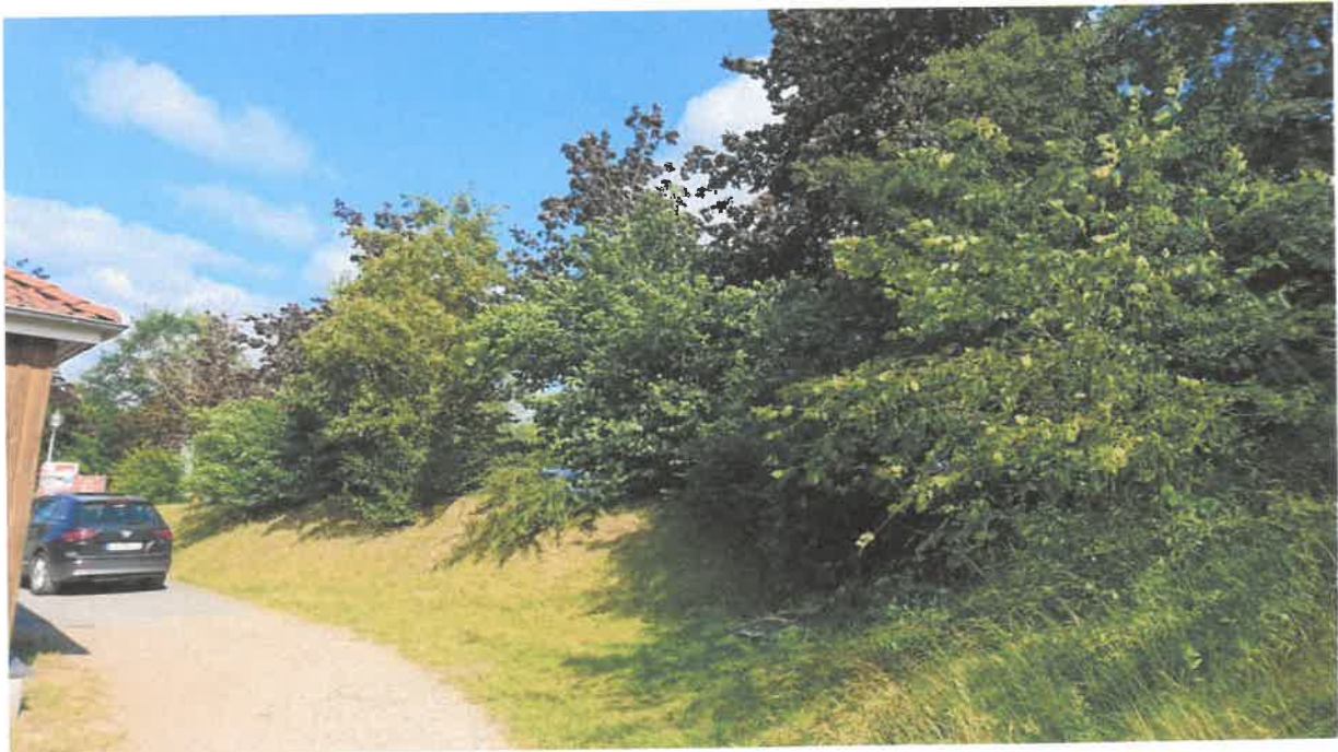
Foto 1: Böschung mit zu entfernendem Gehölzbestand (ca. 150 m 2 )
