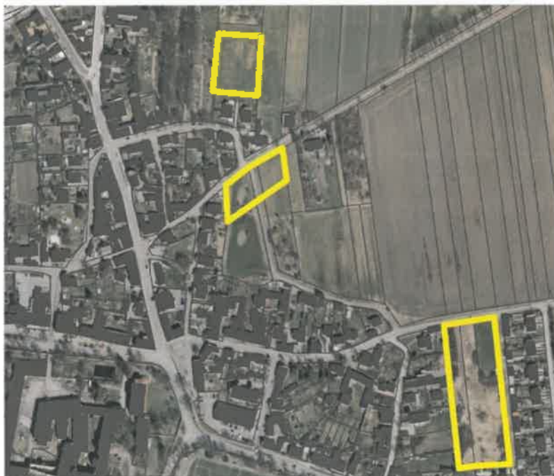
Luftbild des Bereiches der geplanten Wohnbauflächen in Erxleben südlich und nördlich des Alvensleber Weges (Nr. 10) und westlich des Birkenweges (Nr. 11)
