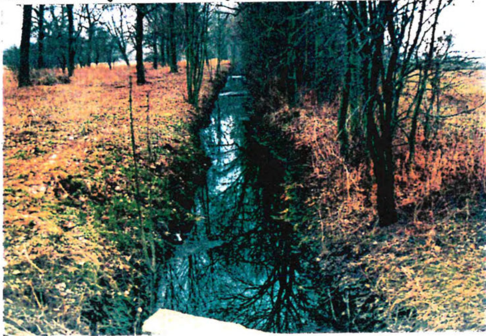
Zustand des Marbegrabens im Einleitungsbereich
