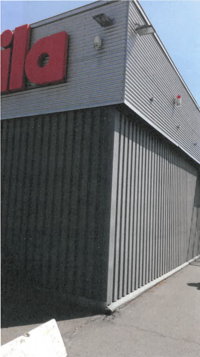
Umlaufende Dachkanten ohne Einflugmöglichkeiten für Fledermäuse
