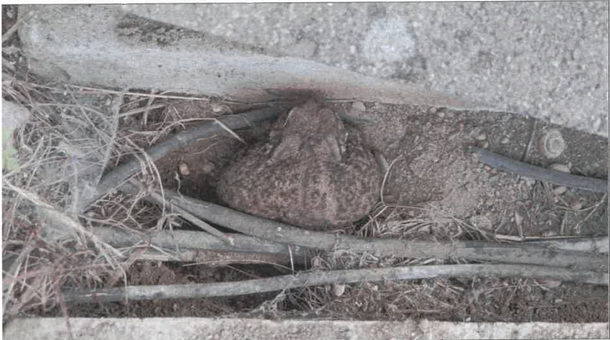
Abbildung 11: Erdkröte in einem alten Kabelschacht (Aufnahme vom 17.08.2017)
