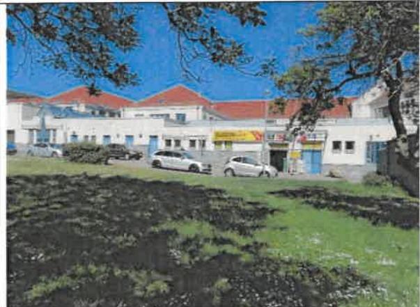
Blick über die Freifläche auf die Rückseite der Rügen-Galerie
