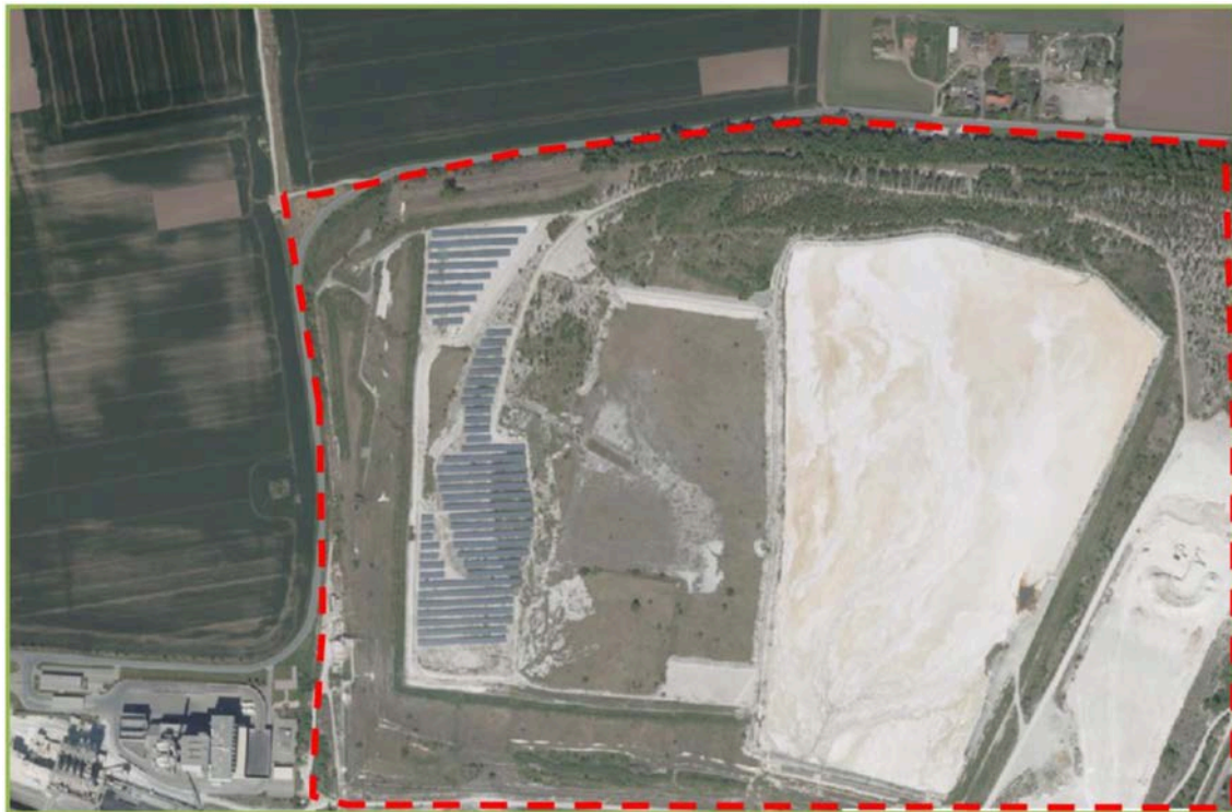
Abb. 4: Fläche mit hohem Artenschutzpotential angrenzend an den Eingriffsraum
