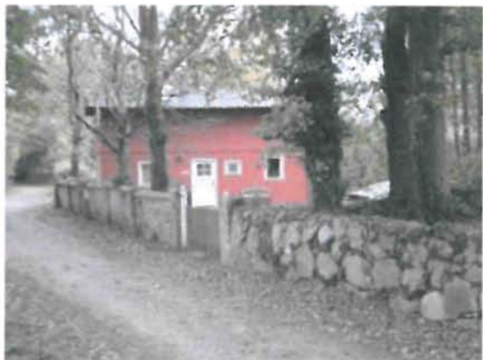
Abbildung 5: Goor 3, bestehendes Wohnhaus (ehemaliges Kutscherhaus); Quelle: eigene Aufnahme
