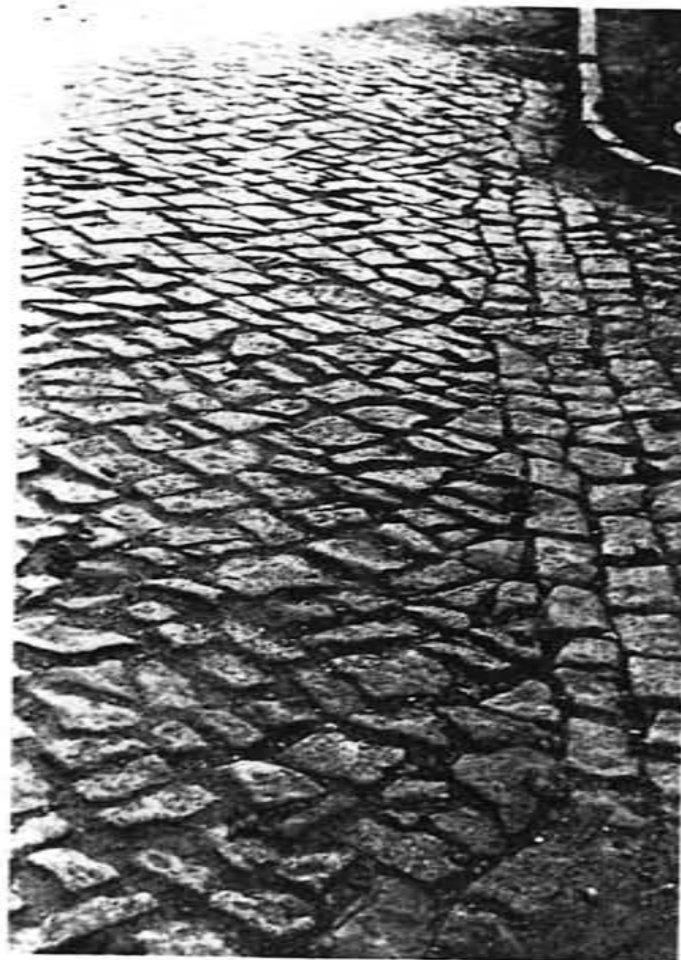
ABB. 2: UNREGELMÄSSIGES IN- PASSE- PFLASTER AUF MARKT/BACHPROMENADE
