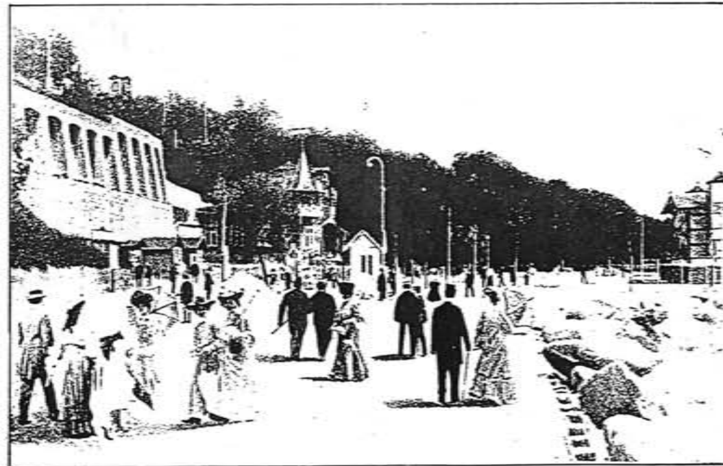
ABB. 3: AM EHEMALIGEN "MIRA MARE" UND KURPLATZ, UM 1900
