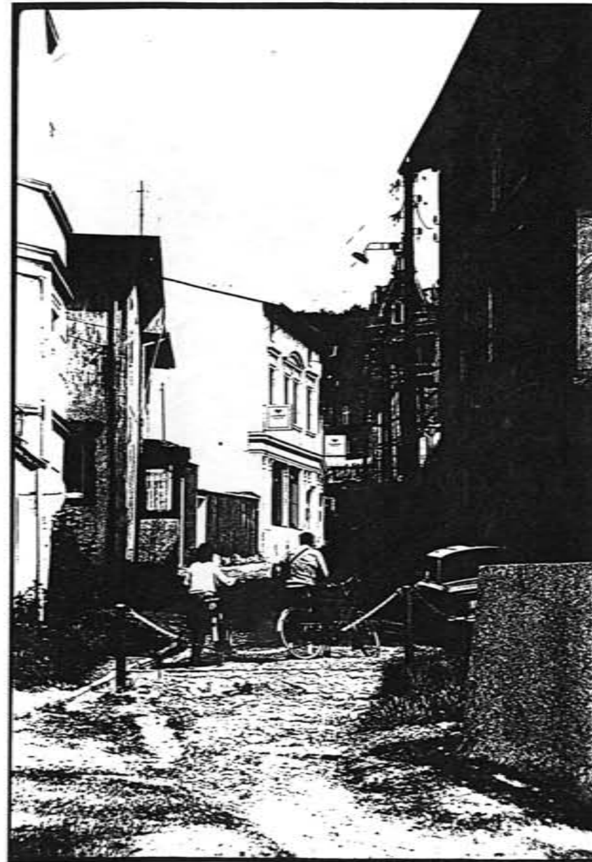
ABB. 2: BLICK AUS UNTEREM TEIL IN RICHTG. EHM. HOTEL "REICHSHOF", ZUSTAND 1991
