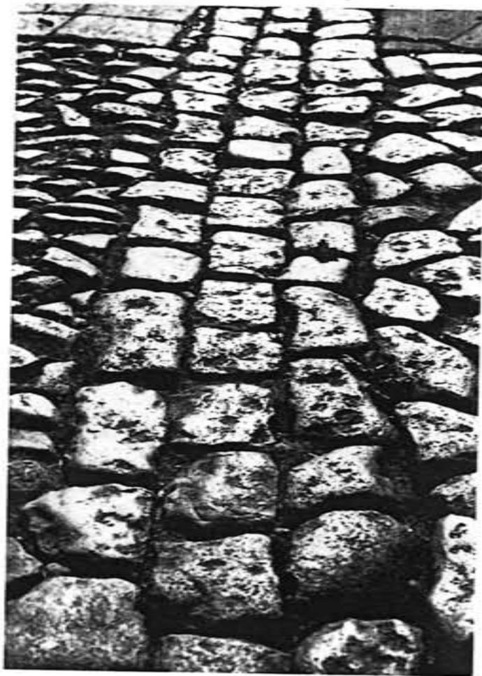
ABB. 1: ENTWÄSSERUNGSRINNE AUF DEM MARKT, 1991
