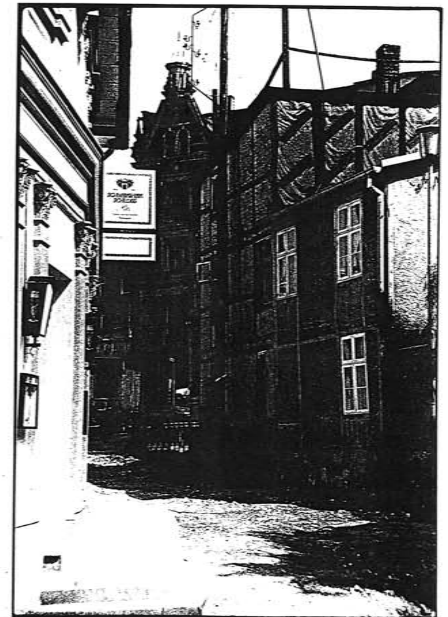
ABB. 3: S. ABB.2, BLICK AUS MITTL. TEIL
