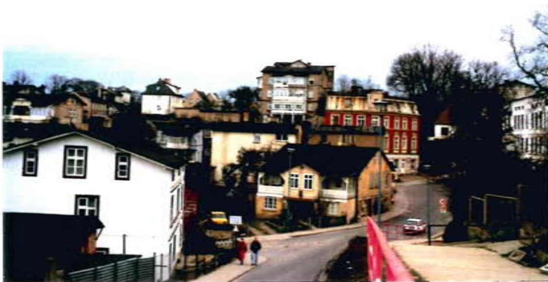
Bergstraße von Osten: Bergstraße 9
