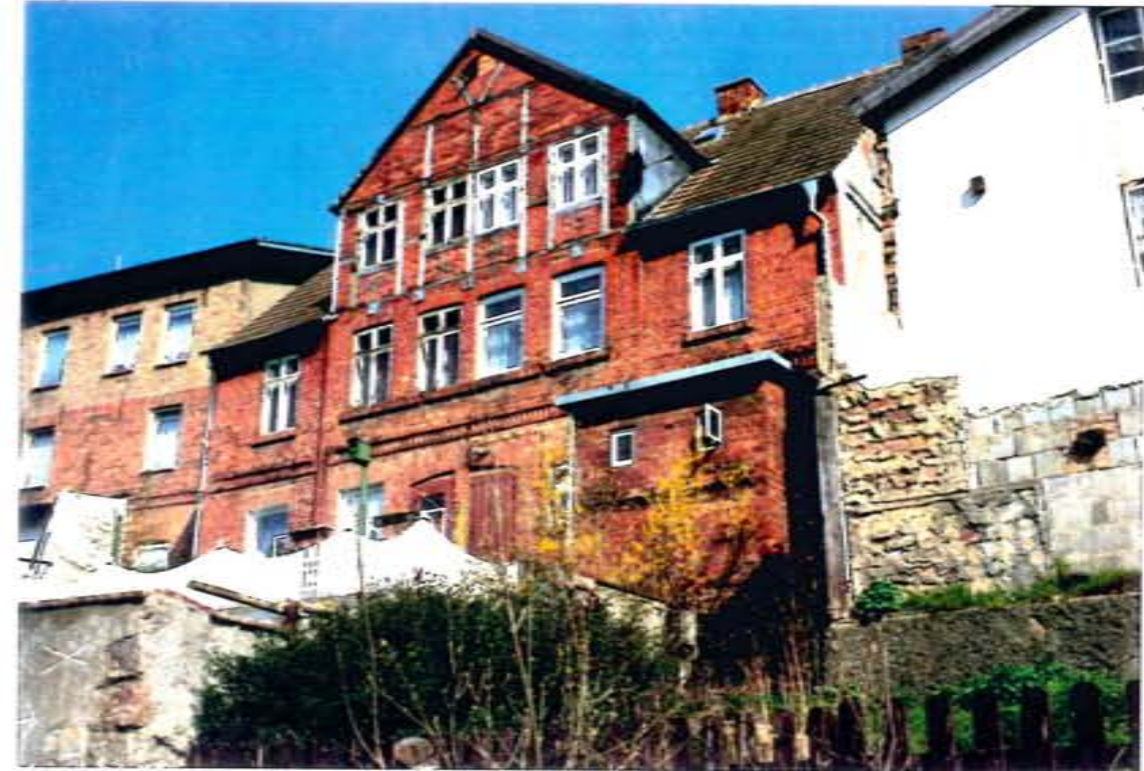
Traufhaus mit Zwerchgiebel, Zwerchgiebel in Fachwerk ausgeführt, Satteldach (ca. 45°)
