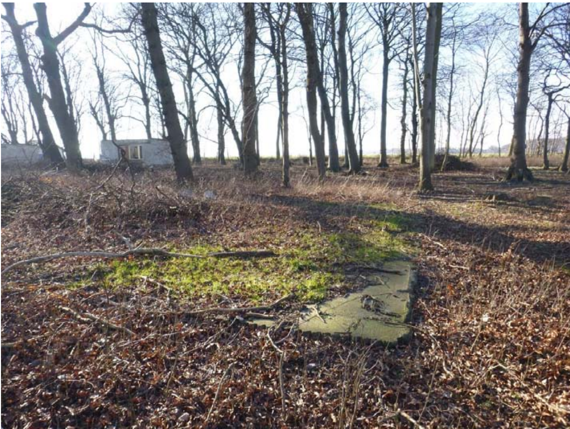
Abbildung 12 Betonfundament im nördlichen Erholungsgarten, im Hintergrund Bungalows
