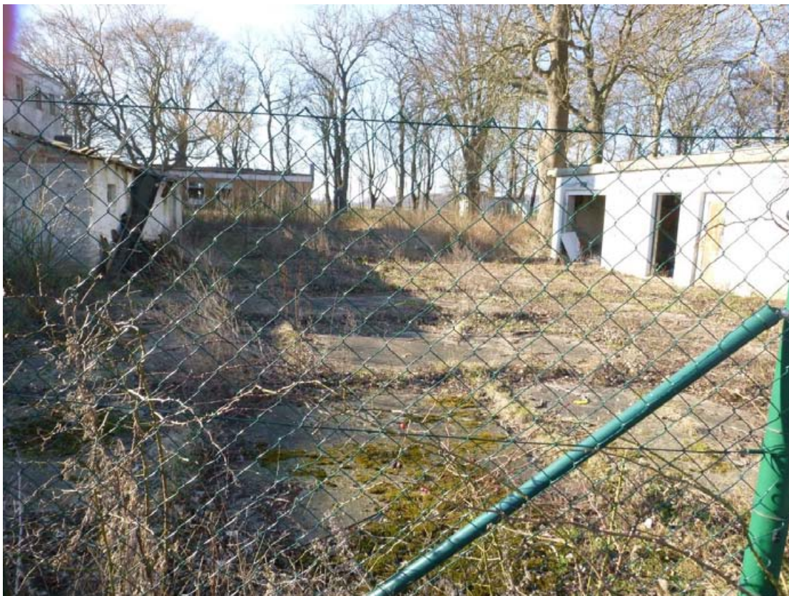
Abbildung 8 Betonfläche im ehemaligen Wirtschaftshof, nördlich Gutshaus, im Hintergrund Küchentrakt
