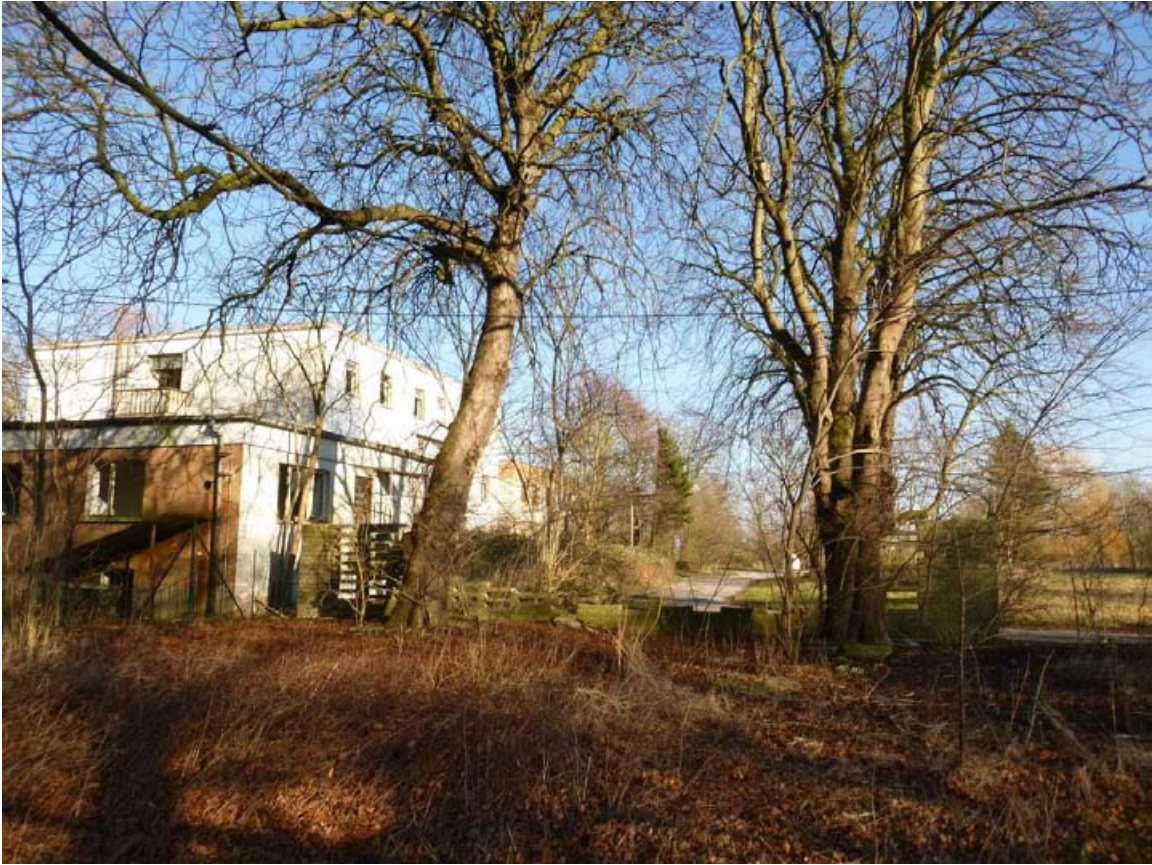
Abbildung 3 Südlich des Gutshauses, Blick aus Richtung Osten
