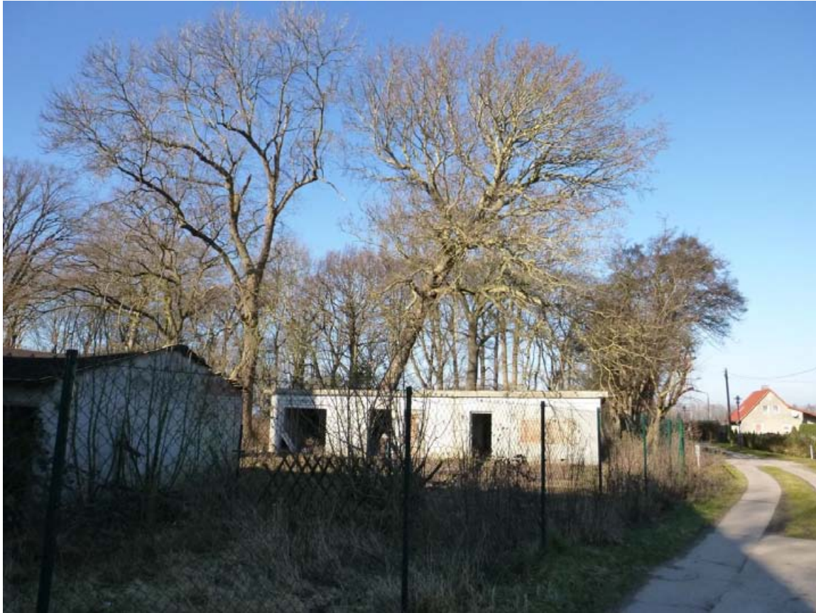
Abbildung 7 Bebauung an der östlichen Parkgrenze im ehem. Erholungsgarten
