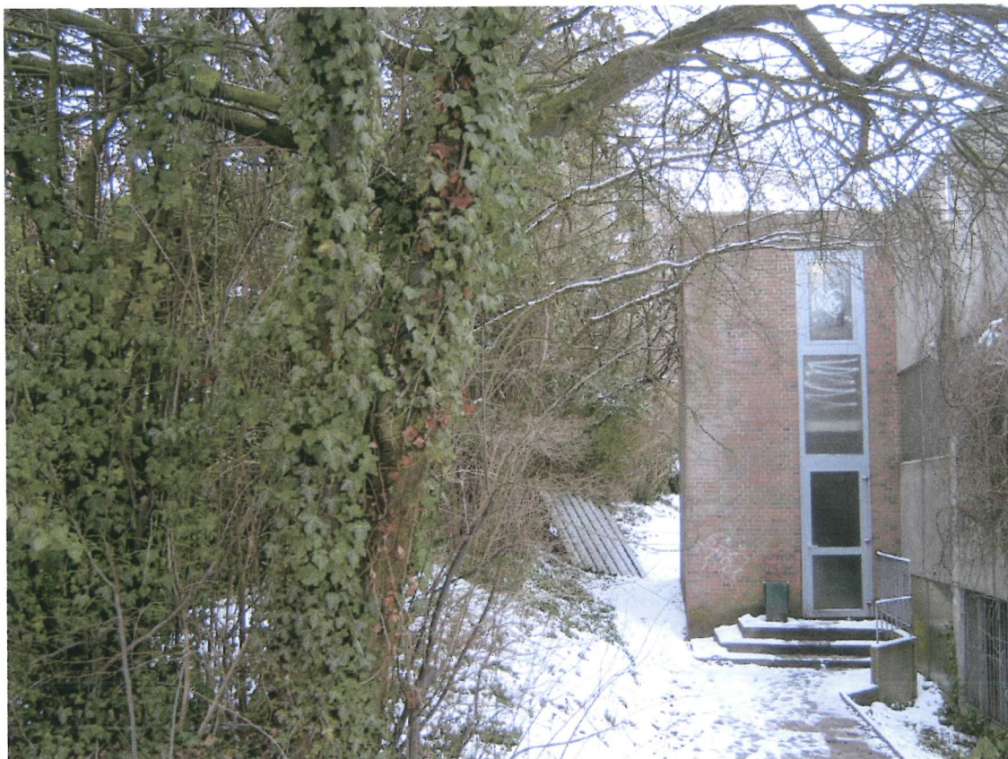
Abbildung 9 Übergangsbereich zwischen Garten und benachbartem Parkhaus. Auch hier breitet sich zunehmend der Efeu über die Gartengehölze aus.
