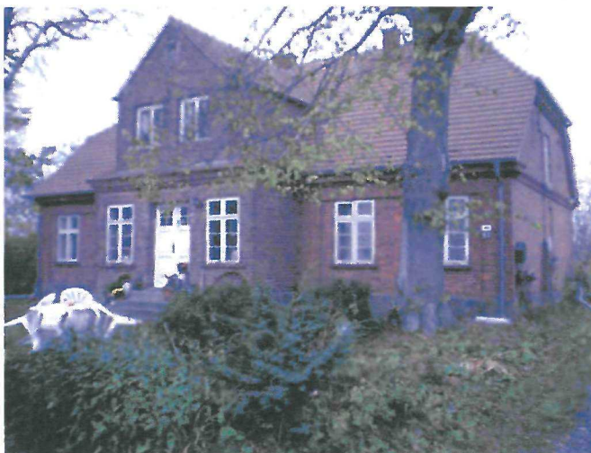
Abbildung 5 Goor 5, Ansicht Wohnhaus
