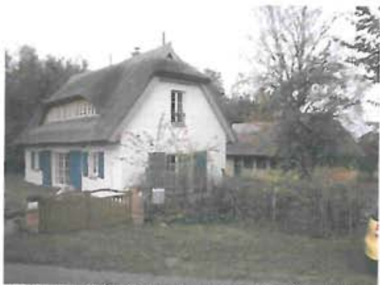
Abbildung 4: Bestandsgebäude „Goor 1“ im Plangebiet
