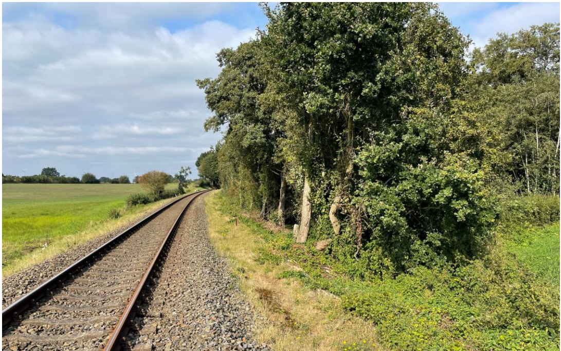
Gleis im Westen des Teilbereichs 4 (Foto: PLOH).
